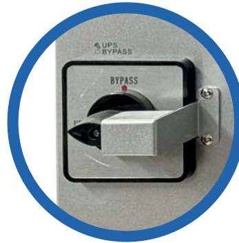
Conmutador de BYPASS de mantenimiento
