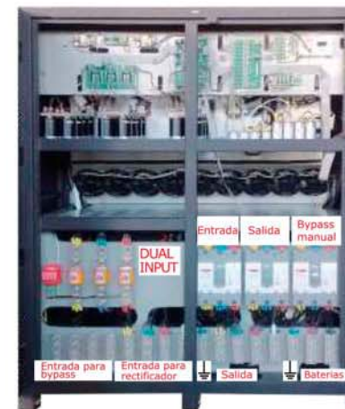
Figura 3.5 Vista forntal sin tapa UPS 160kva
